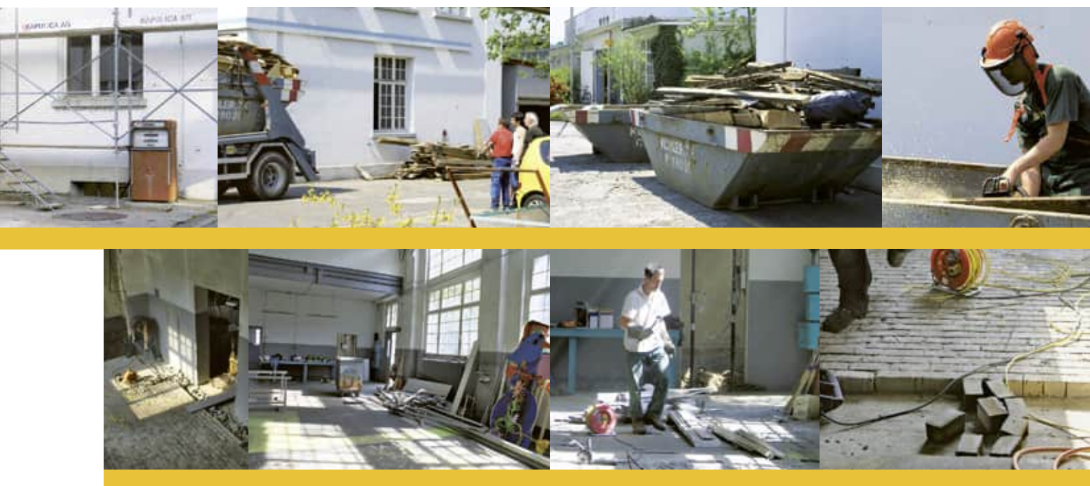
Umbau der Werkhalle: Einrüsten, entsorgen, Holzboden demontieren
